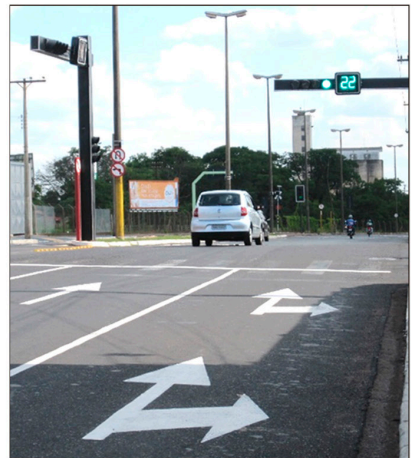
Estrutura projetada com temporizador (luz verde)
