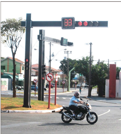
Estrutura projetada com temporizador (luz vermelha)
