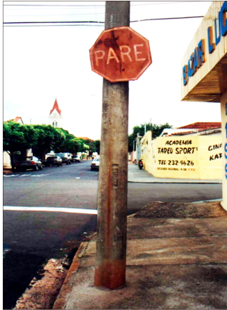
Placa em poste comum
