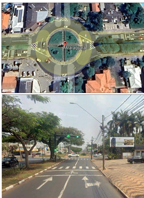
Figura 3.21 Fotografias de rotatória com controle de semáforo à distância.
