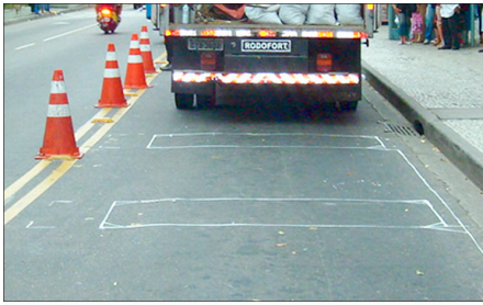
Recorte do pavimento para cabos de laços indutivos
