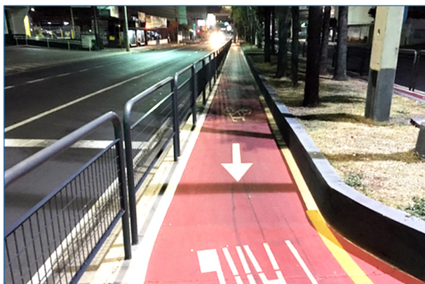
Figura 2.12 Ciclovia separada da pista por gradil. Fonte: Foto dos autores.
