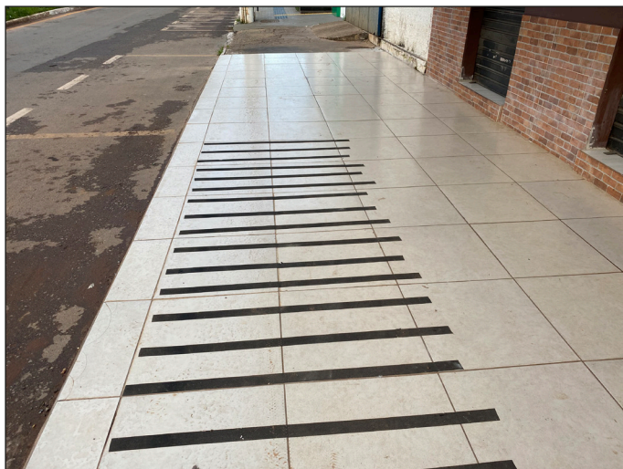
Figura 8.30 Calçada com revestimento escorregadio amenizado pela colocação de tiras com material antiderrapante. Fonte: Foto dos autores.
