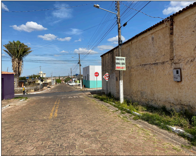
Figura 8.25 Calçada muito estreita, malconservada e obstruída por poste junto a terreno particular. Fonte: Foto dos autores.
