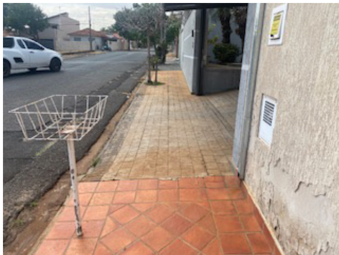
Figura 8.41 Rampa de garagem adequada. Fonte: Foto dos autores.
