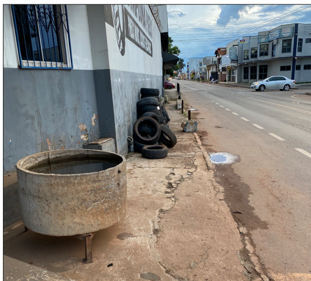
Figura 8.14 Calçada obstruída por peça de ferro e pneus usados. Fonte: Foto dos autores.
