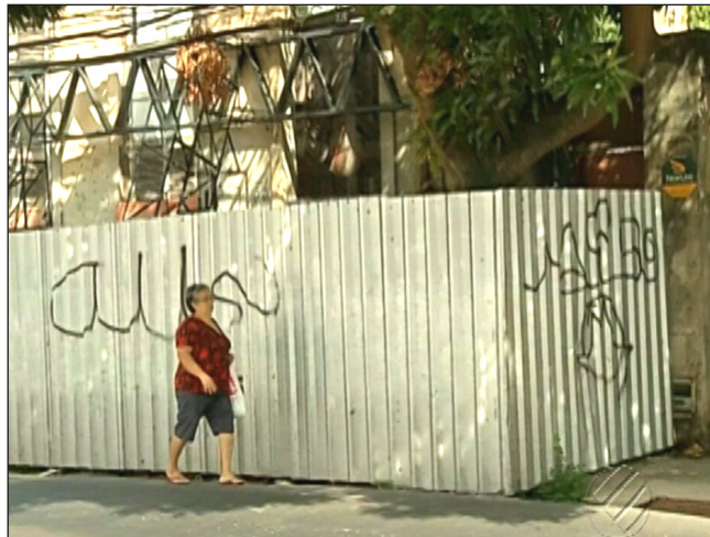
Figura 8.17 Obstrução total da calçada com tapume. Fonte: Internet.
