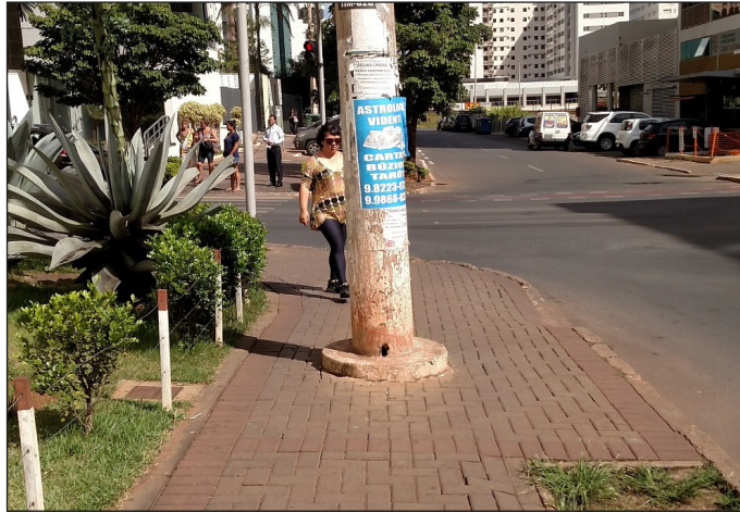
Figura 8.4 Calçada obstruída por poste. Fonte: Internet.
