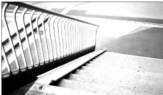
Figura 1.12 Canaleta para conduzir a bicicleta em escada na cidade de Viena, Áustria. Fonte: Foto dos autores.
