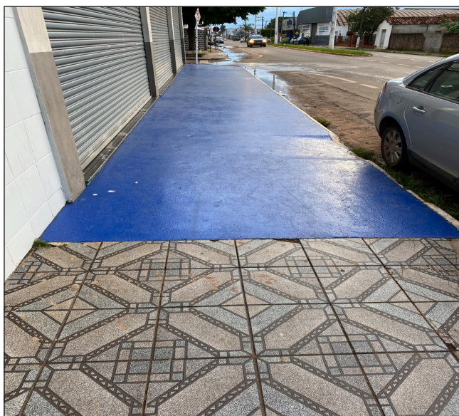
Figura 8.38 Calçada de concreto pintado com largura suficiente e piso regular não escorregadio. Fonte: Foto dos autores.
