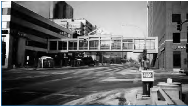
Figura 1.4 Travessia aérea protegida em Minneapolis, Estados Unidos. Fonte: Foto dos autores.
