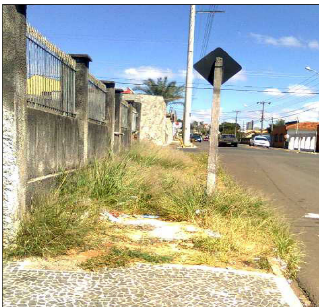
Figura 8.3 Calçada sem revestimento e com mato. Fonte: Foto dos autores.
