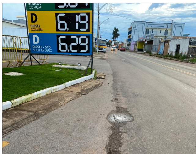
Figura 8.15 Calçada sem revestimento e com obstrução por placa de propaganda. Fonte: Foto dos autores.
