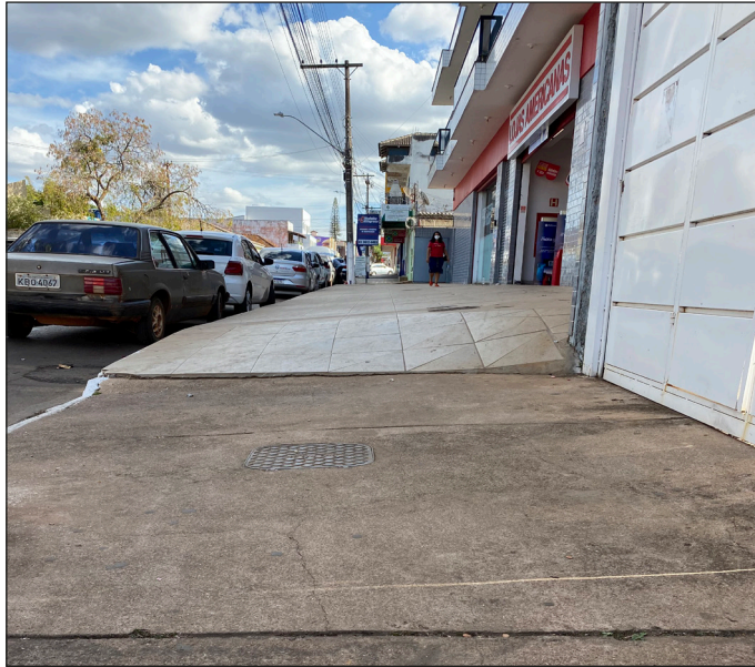
Figura 8.28 Calçada com declive longitudinal acentuado. Fonte: Foto dos autores.
