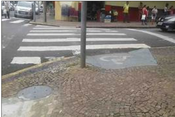
Figura 8.52 Rampa de acessibilidade adequada, mas falta piso tátil. Fonte: Foto dos autores.
