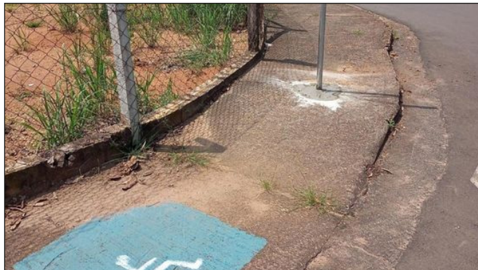
Figura 8.5 Calçada obstruída por postinho de sinalização. Fonte: Internet.
