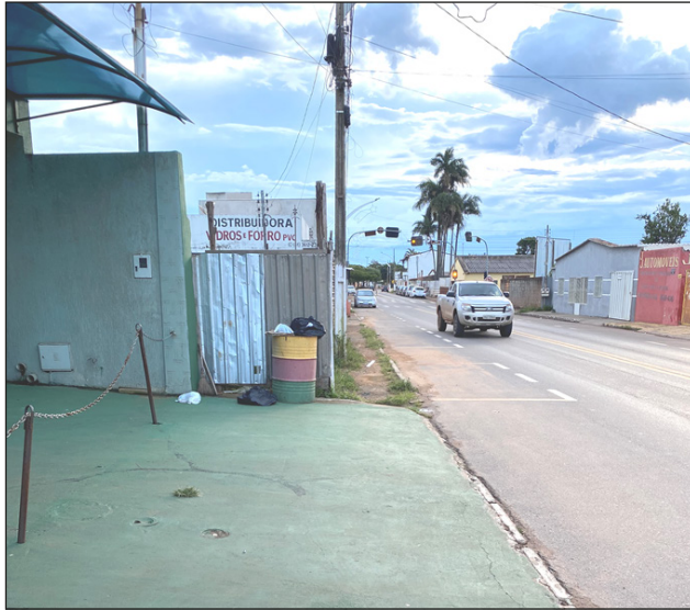
Figura 8.16 Obstrução quase total da calçada com tapume. Fonte: Foto dos autores.
