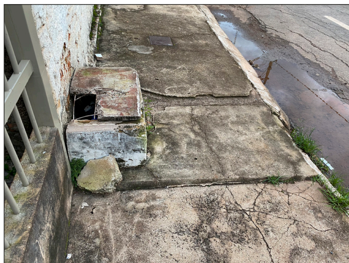
Figura 8.22 Aparelho medidor do consumo de água invadindo o espaço público e obstruindo parte da calçada. Fonte: Foto dos autores.
