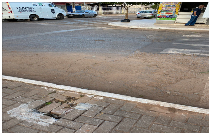
Figura 8.29 Falta de guia rebaixada e faixa de pedestres em esquina movimentada com sinal de PARE. Fonte: Foto dos autores.
