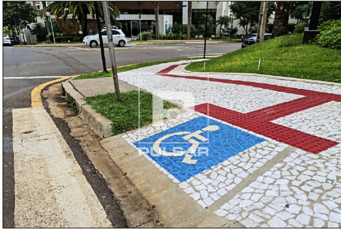
Figura 8.51 Rampa de acessibilidade com piso tátil. Fonte: Internet.
