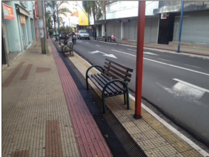
Figura 8.47 Calçada larga (bulevar) com piso tátil em rua comercial. Fonte: Foto dos autores.
