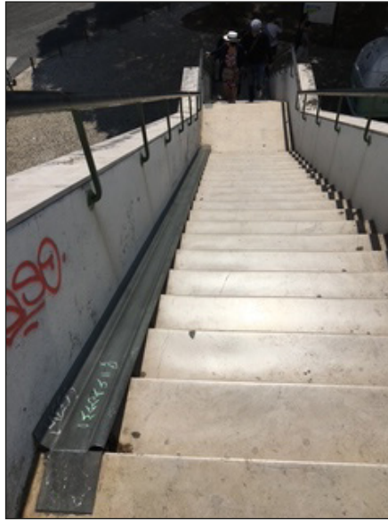
Figura 5.12 Escada com canaleta lateral para conduzir a bicicleta.
