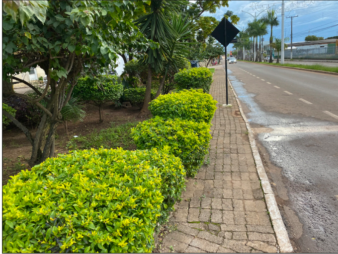
Figura 8.24 Calçada muito estreita e obstruída por postinho de sinalização junto a terreno público. Fonte: Foto dos autores.
