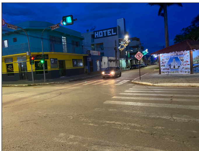
Figura 8.35 Cruzamento semaforizado sem guia rebaixada e com faixas de pedestres parcialmente apagadas. Fonte: Foto dos autores.
