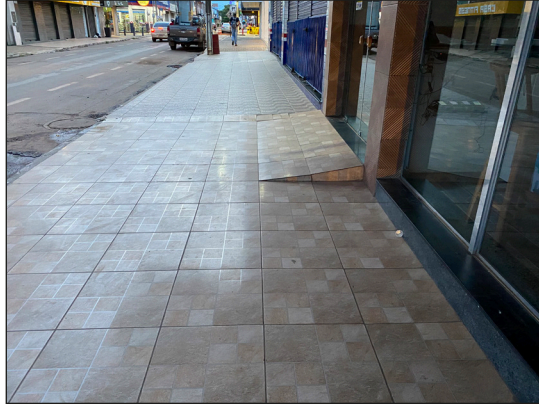
Figura 8.43 Rampa de garagem em calçada com largura suficiente, aceitável se houvesse sinalização com piso tátil. Fonte: Foto dos autores.
