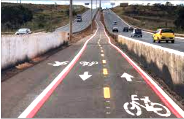
Figura 2.13 Ciclovia separada de rodovia por barreira de contenção.
