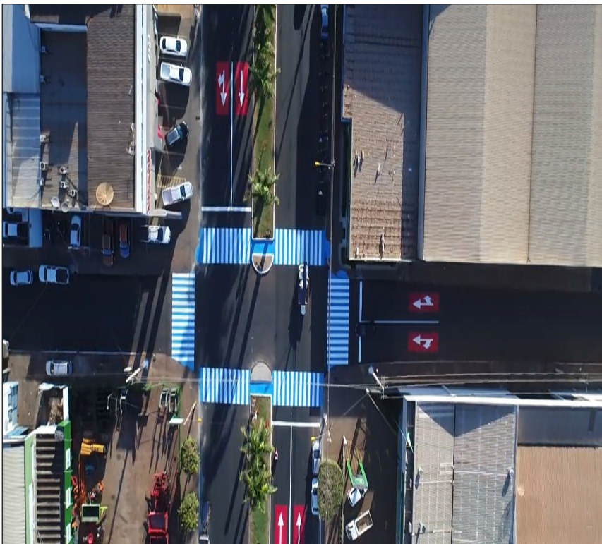
Figura 8.44 Faixa de pedestre com sinalização horizontal chamativa. Fonte: Foto dos autores.
