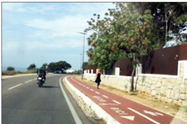
Figura 2.4 Calçada para uso de pedestres e bicicletas, separada por linha de demarcação. Fonte: Internet.
