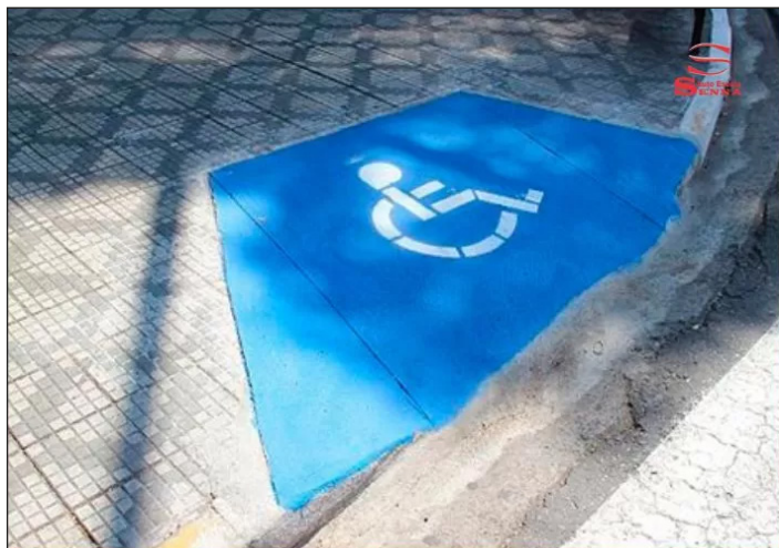
Figura 8.53 Detalhe de rampa de acessibilidade (guia rebaixada). Fonte: Internet.
