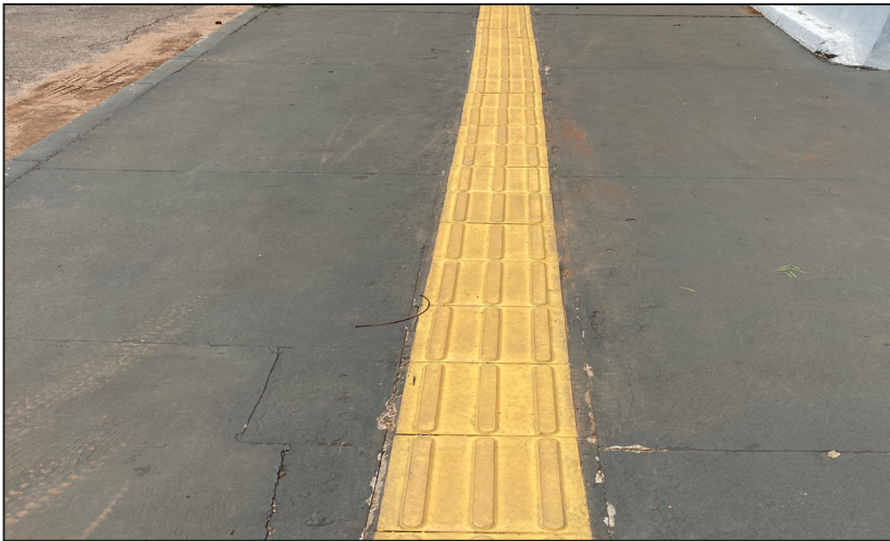
Figura 8.40 Calçada regular não escorregadia com piso tátil. Fonte: Foto dos autores.
