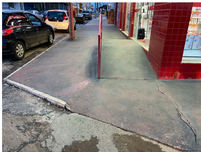
Figura 8.42 Rampa de acessibilidade à loja com corrimão, sem prejuízo ao trânsito de pedestres (falta sinalização com piso tátil). Fonte: Foto dos autores.
