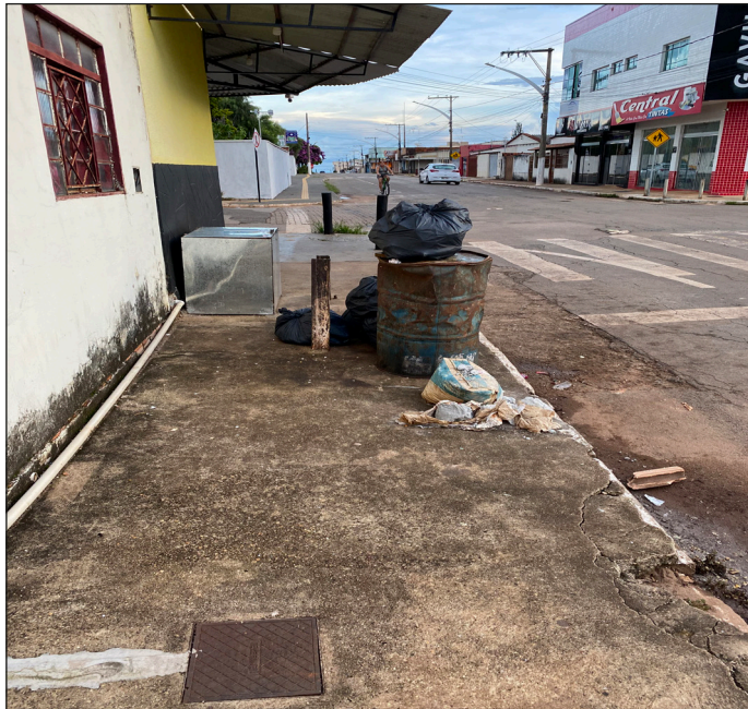
Figura 8.21 Obstrução de calçada por trilhos fixados, objetos e lixo.
