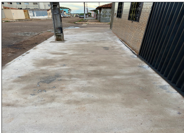
Figura 8.37 Calçada de concreto aparente com largura suficiente e piso regular não escorregadio. Fonte: Foto dos autores.
