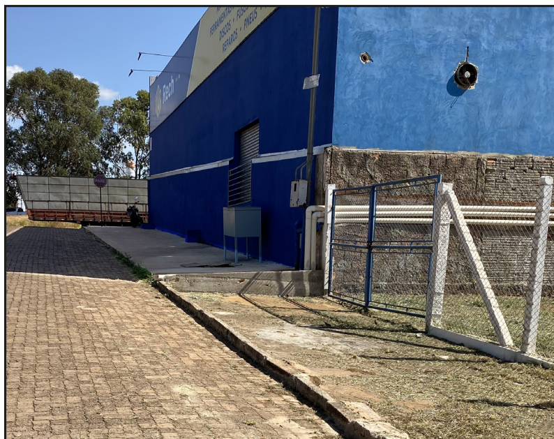
Figura 8.27 Calçada com degrau acentuado. Fonte: Foto dos autores.
