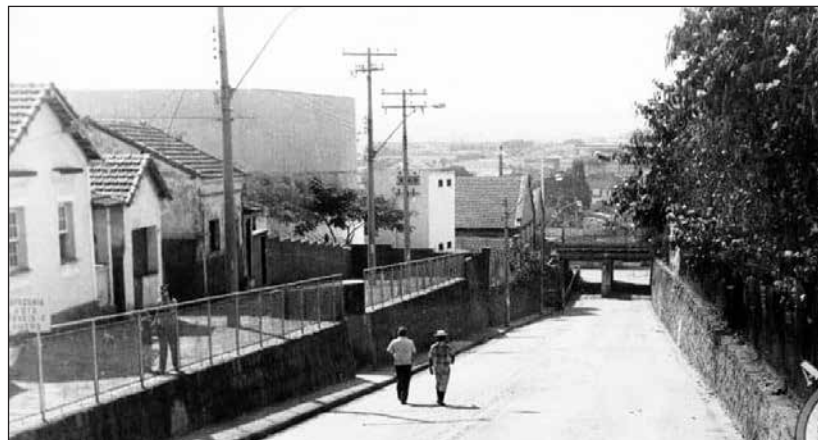
Fig. 16 Viaduto Travessa Oito - passagem sob trilho. Acervo FPMSC.
