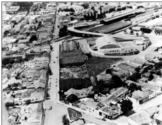
Fig. 31 Vista aérea região estação ferroviária com Viaduto 4 de Novembro ligando região central ao Bairro Vila Prado, com Indústria de Móveis Moyster e Serraria Giongo. Década 1970. Foto: volksclubesaocarlos.blogspot.com
