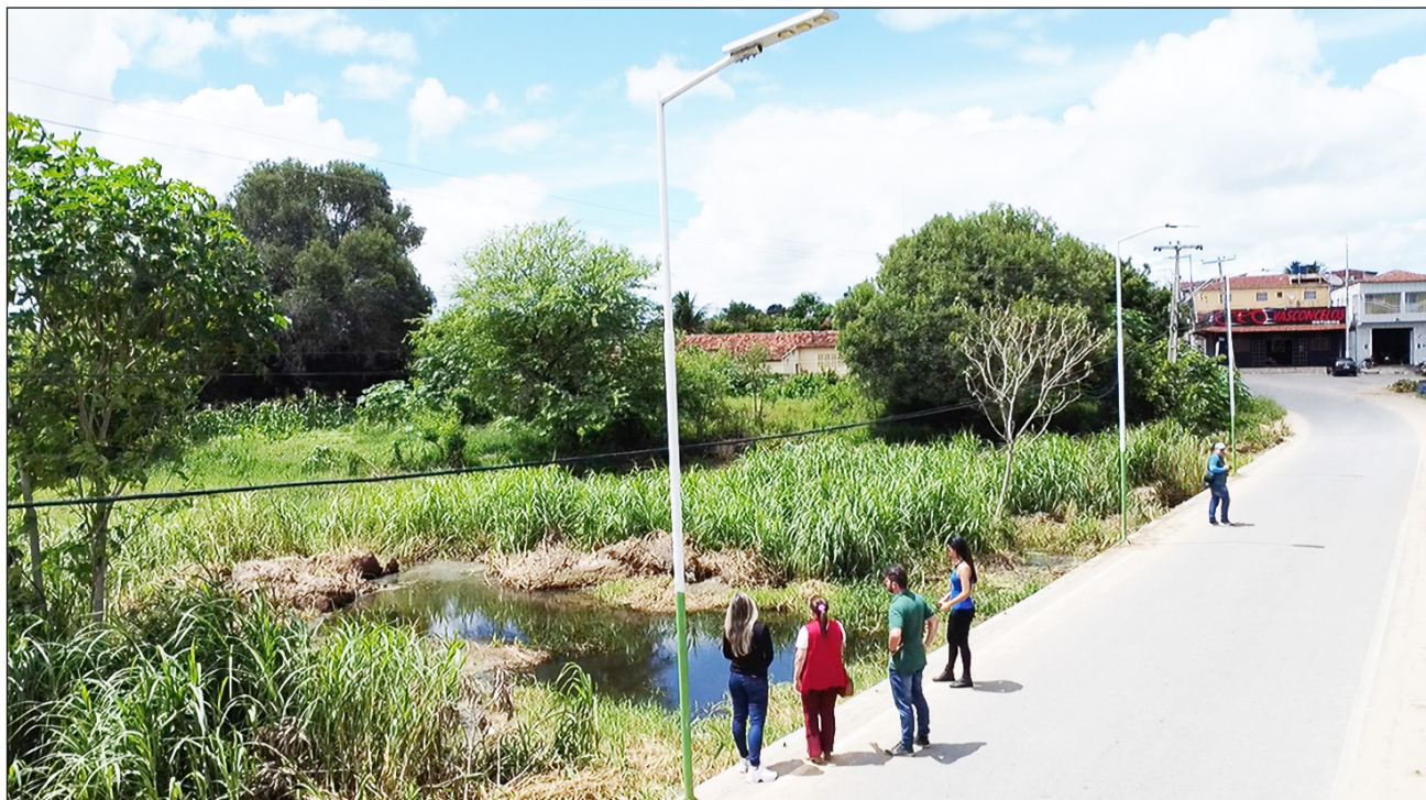
Figura 6.13 Ponte do Bairro do Pilão sobre o Rio Poção. Fonte: Foto dos autores.
