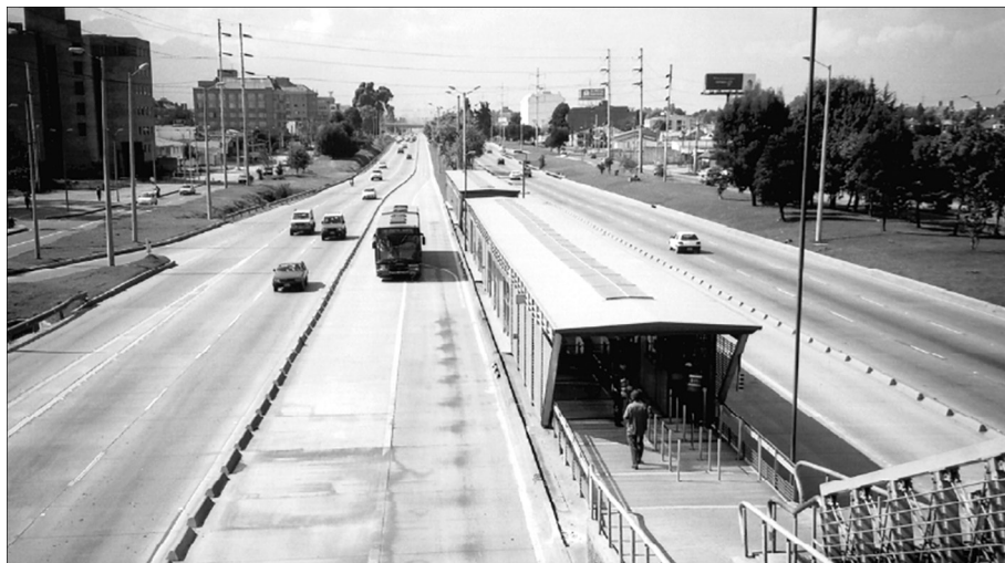
Faixa segregada (caneleta) do sistema Transmilenio em Bogotá, Colômbia.
