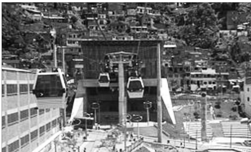
Linha e estação do teleférico de Medellín.
