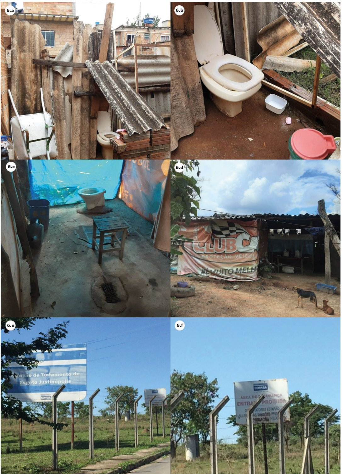
Figura 6: Caracterização da precariedade do espaço e dos elementos internos e externos constituintes do banheiro e inaccessibilidade a serviços de esgoto, a saber: na Ocupação Eliana Silva (6.a; 6.b) e no Assentamento Ho Chi Minh (6.c; 6.d). Placas de sinalização defronte à Estação de Tratamento de Esgoto da COPASA, no distrito de Justinópolis em Areias (6.e; 6.f). Imagens: os autores.
