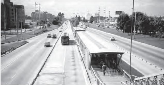
**Figura 3.42** Faixa segregada (caneleta) do sistema Transmilenio em Bogotá, Colômbia, com duas faixas de tráfego junto às estações. *Fonte:* Foto feita pelos autores.
