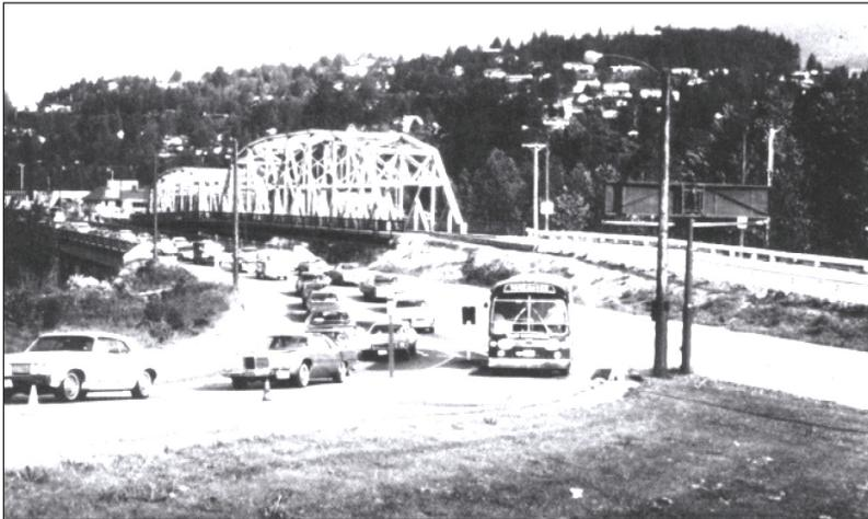
**Figura 14.10** Acesso exclusivo para ônibus na entrada de uma via expressa. *Fonte:* Vuchic (1981).
