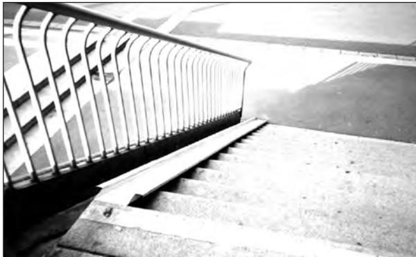
**Figura 3.12** Canaleta para conduzir a bicicleta em escada na cidade de Viena, Áustria.
