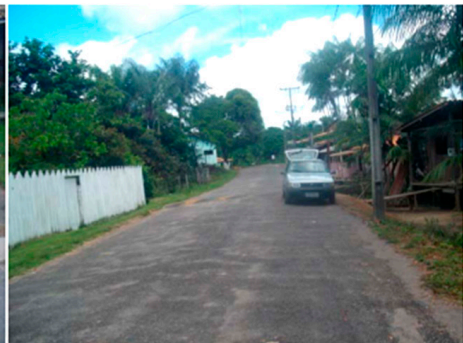
d) Tramo asfaltado de la calle Antero Lobato.
