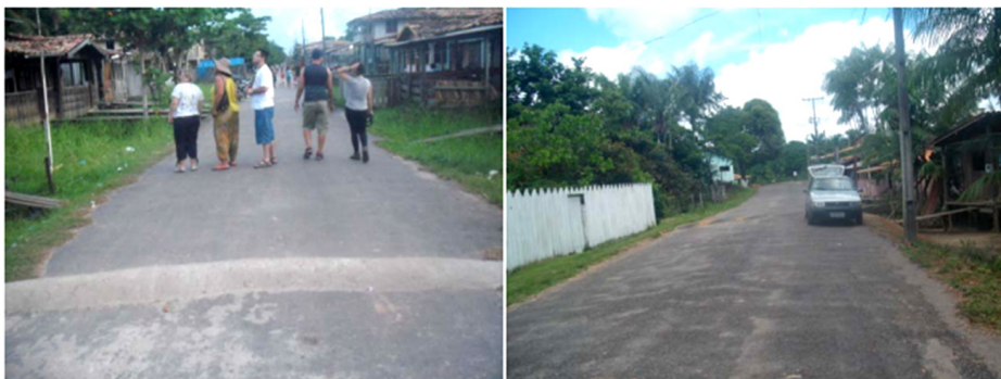
c) Trecho da rua Antero Lobato asfaltada.
